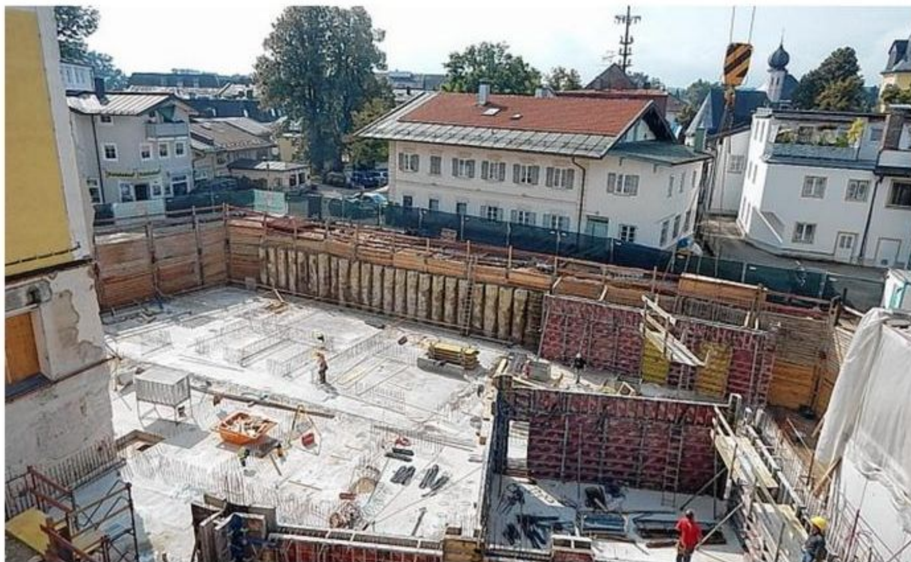
Ein Riesenloch mitten in Prien: Die Größe der Baugrube lässt ahnen, dass an der Schulstraße etwas Großes entsteht: Über zehn Millionen Euro gibt der Landkreis Rosenheim für den Neubau der staatlichen Realschule aus, die räumlich mit ihrer kommunalen Schwesterschule vereint wird. Letztere muss sich mit der Baustelle nebenan arrangieren und vor allem auf ihre Aula verzichten, die für den Bau eines größeren, gemeinsamen Saals beider Schulen abgerissen wurde.
